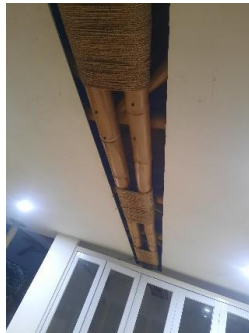
Gambar 9. Bagian Balok Bambu yang Diekspos pada Ceiling Kantor RLA Studio (Sumber: Penulis, 2025)
