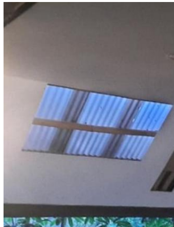
Gambar 11. Skylight pada Lantai 2 Kantor (Sumber: Penulis, 2025)
