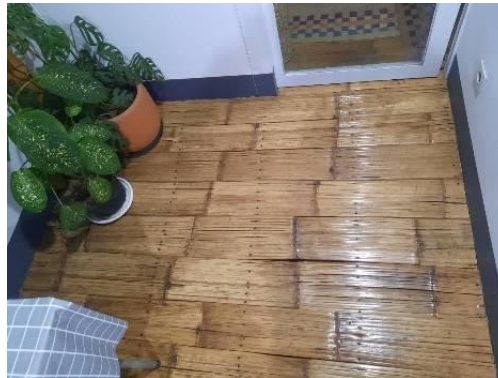
Gambar 6. Lantai Palupuh pada Kantor RLA Studio (Sumber: Penulis, 2025)
