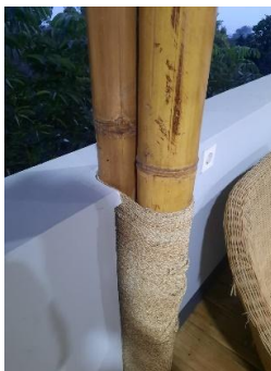
Gambar 10. Kolom Bambu Dengan Dinding Beton (Sumber: Penulis, 2025)
